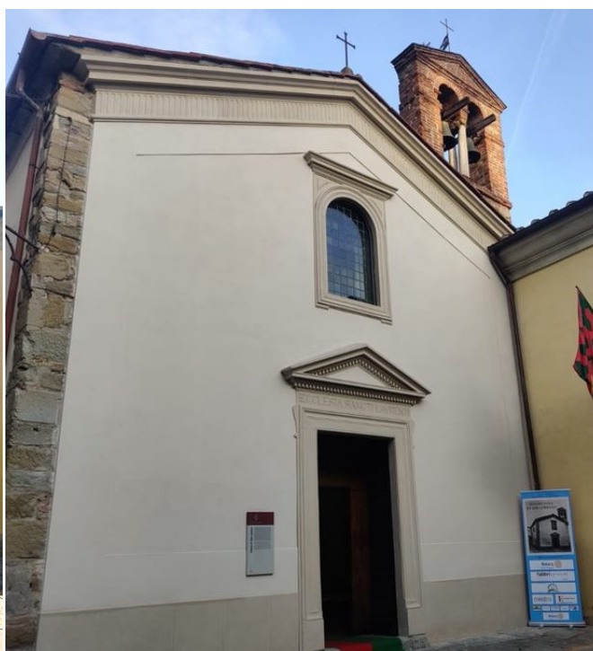
Restauro Chiesa di S.Lorenzo
